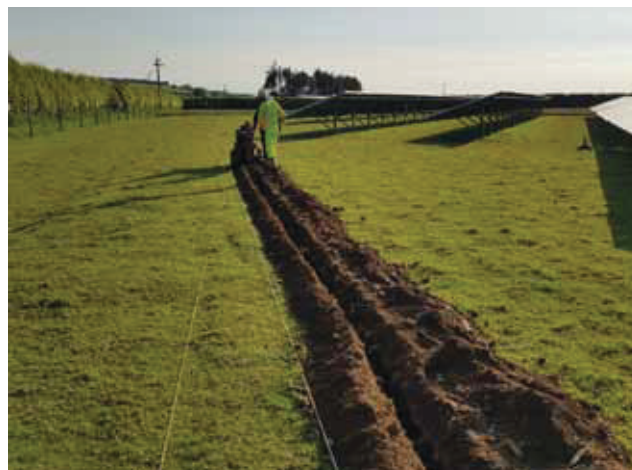
Erdarbeiten für das Schutzsystem
